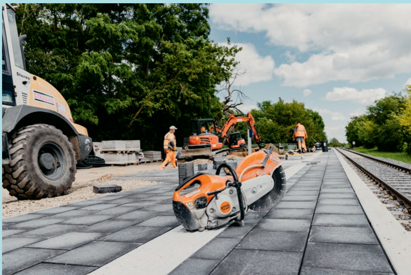
Auf neuen Wegen: Allein sieben Bahnstationen entlang der neuen S11 werden derzeit herausgeputzt.
